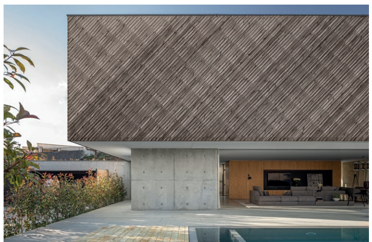
■ Casa A, Portugal, von REM'A arquitectos, Foto: Ivo Tavares Studio
